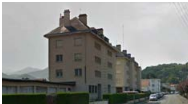
Photo 25 : Immeubles discontinus à Lourdes, rue des Chalets (Source : Volet « Paysage et morphologie urbaine » du projet de territoire. / Réalisation : AUAT).
